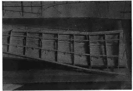
写真1 組み立て中の九七艦攻の主翼
